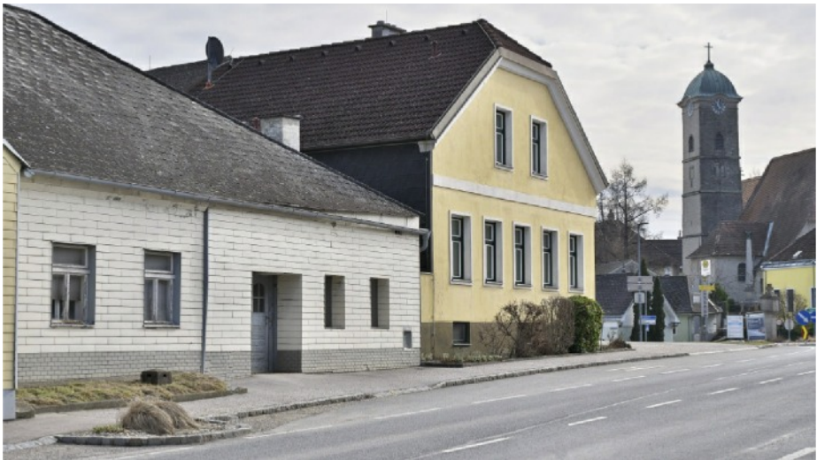
Schleinbacherstraße 4, weißes Haus links, an Stelle dieses Hauses stand ehemals das Haus Ulrichskirchen Nr. 88, das Geburtshaus von Juliana Weiskircher
